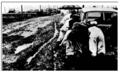
写真 終戦直後の日本の道路の状況 出典:「フタキンス調査団名古屋・神戸高速道路調査報告書」
