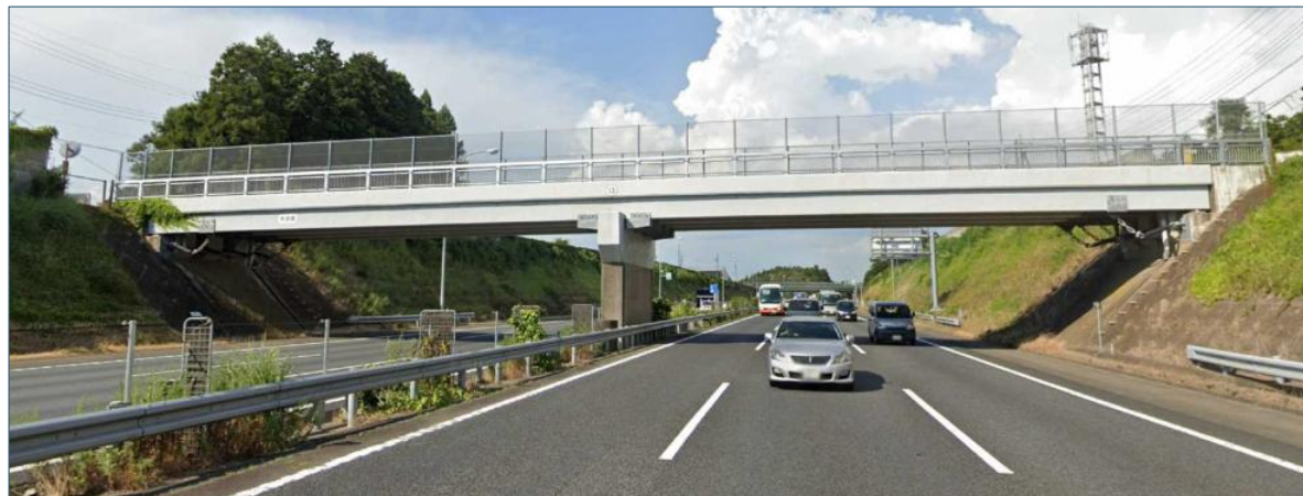
2 径間連続PC橋（中央分離帯に橋脚あり）
