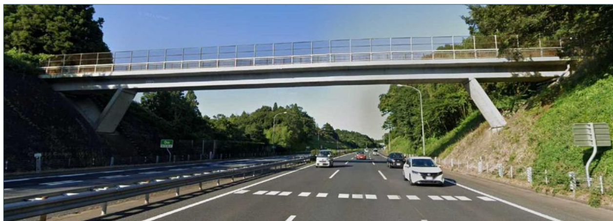
PC箱形π型ラーメン橋（中央分離帯に橋脚なし）
