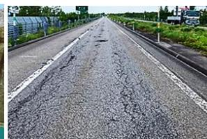
アスファルト路盤の損傷
