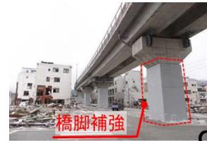
耐震補強例（釜石高架橋）
