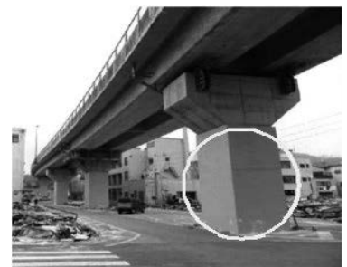
< 橋脚の耐震補強 >
