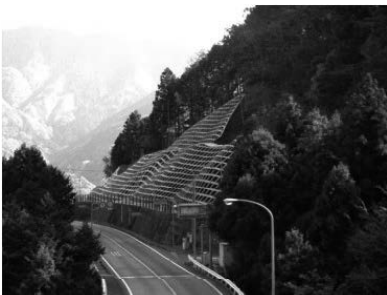
< 斜面崩落防止対策 >
