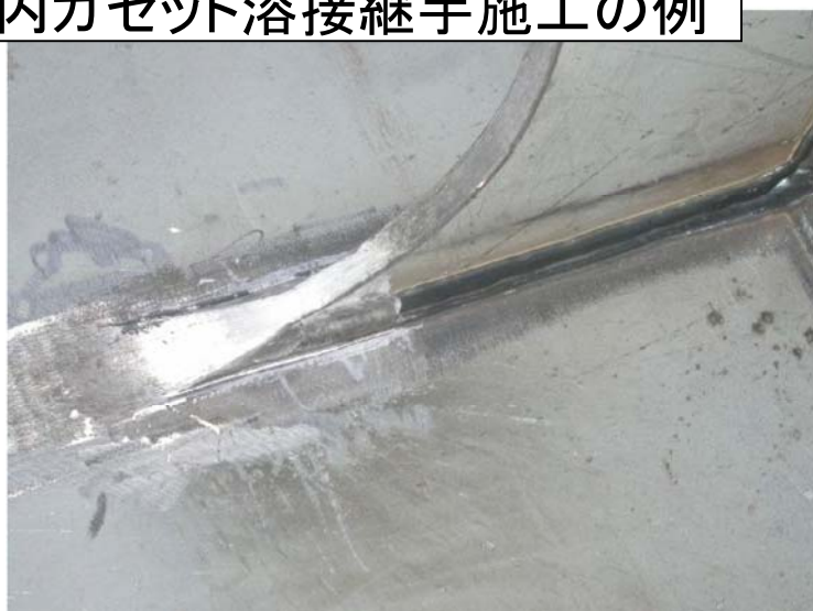
面外ガセット溶接継手施工の例
