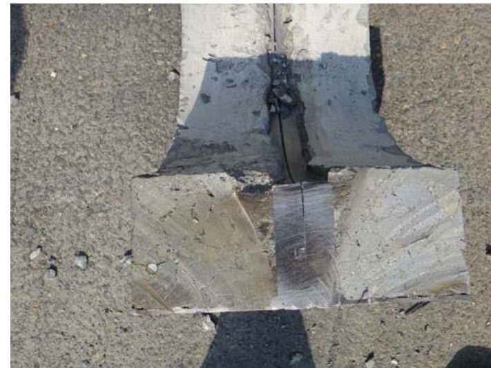
PHC杭現場溶接継手部の切断状況
