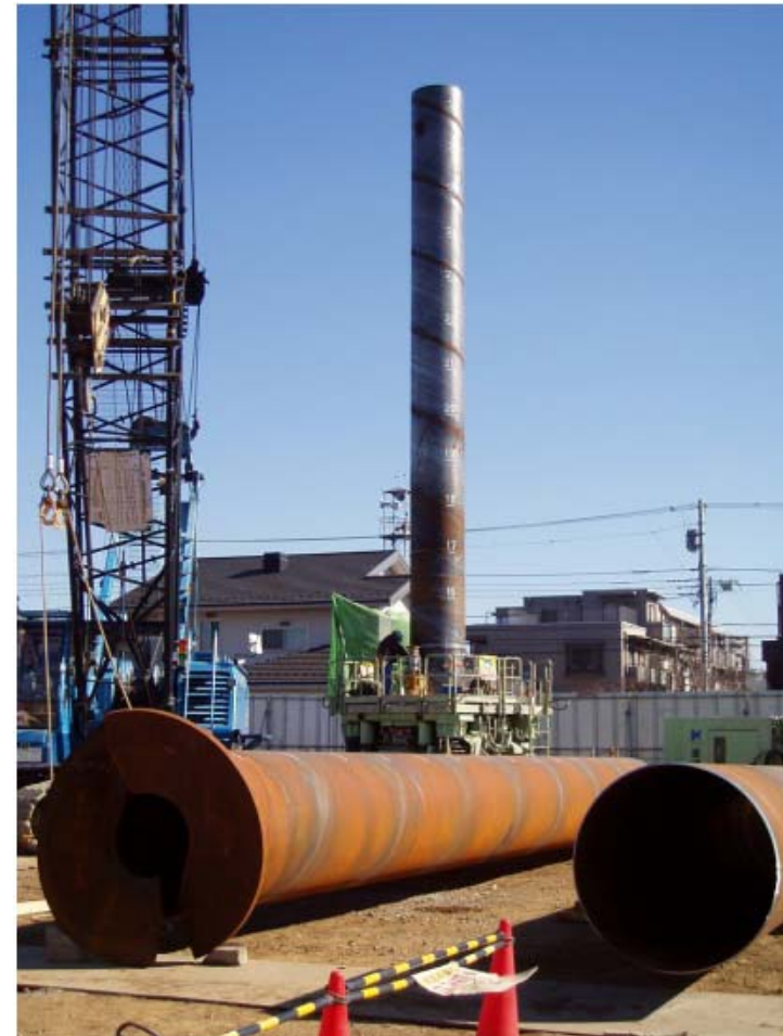
回転杭と回転杭工法の施工状況の例
