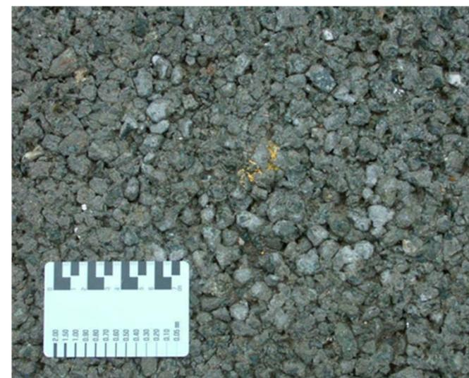
連続空隙を有するポーラスコンクリートを表層に用い、コンクリート舗装版に排水機能や透水機能、自動車騒音低減機能などの環境負荷低減性能を持たせたコンクリート舗装のこと。ポーラスアスファルト舗装のような空隙つぶれ現象がなく、タイヤの旋回・据切り作用(タイヤでねじられること)による骨材飛散などに対する抵抗性に優れている。
