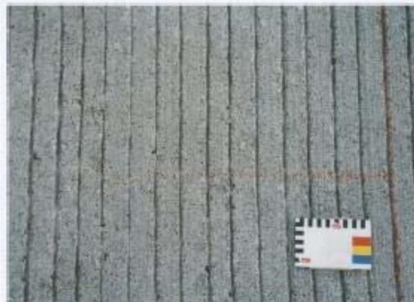
供用直後の路面のマクロなキメを確保し、高速走行下でもすべり抵抗の保持が可能な工法
