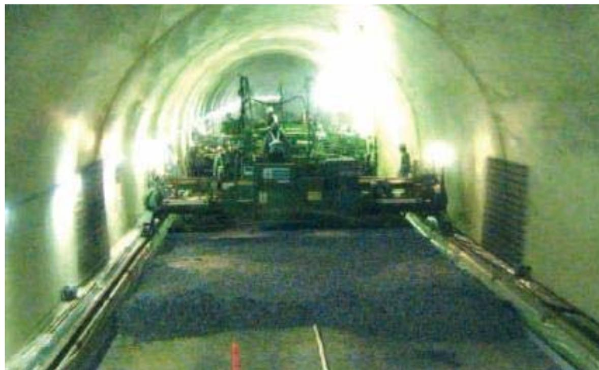
機械の中央部でコンクリート用の舗装機械の角度を変えることができる施工機械を用い、横断勾配の異なる2車線のコンクリート舗装を同時に施工する方法
