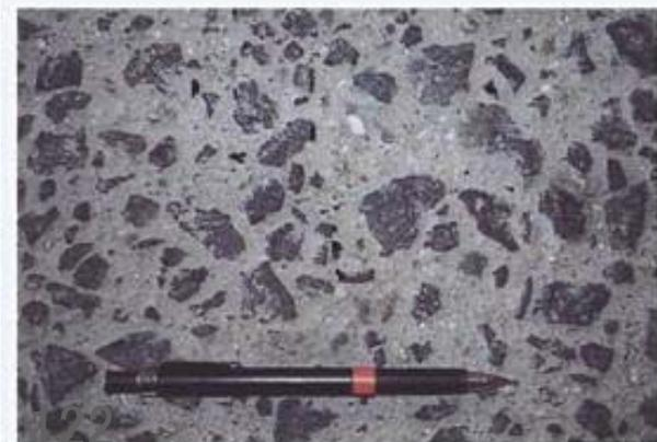
打設直後のコンクリートに凝結遅延剤を散布し、表面が固まらないうちにモルタル分を除去することで、路面に粗骨材を露出させる工法。
