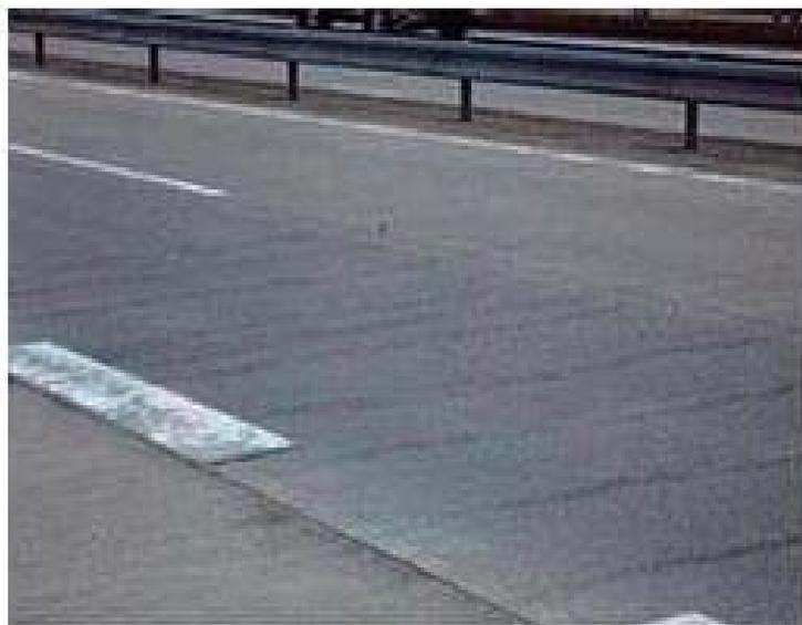
連続鉄筋コンクリート舗装は、縦方向鉄筋によりコンクリートの乾燥収縮や温度降下に起因する横ひび割れを分散発生させる舗装構造であるため、横ひび割れは破損ではない。普通コンクリート舗装に発生するひび割れと比較すると、ひび割れの数や幅が全く異なる。連続鉄筋コンクリート舗装に発生する横ひび割れの間隔は50～200cm程度、幅は0.3mm程度以下となる。
