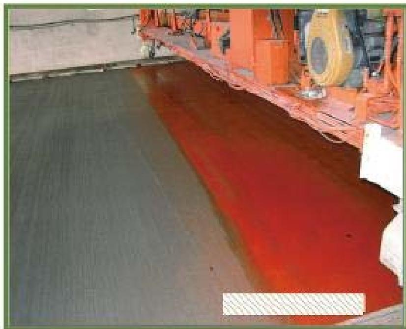
写真-7.4.2 機械による遅延剤の散布例
