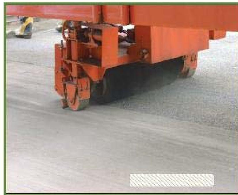
写真-7.4.3 機械による露出作業例
