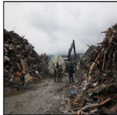
(東日本大震災における道路の啓開状況)
