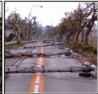
(台風による道路の被災状況)
