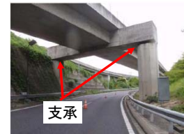
下部構造上の支点が上部構造の橋面の水平投影面上にない場合の例
