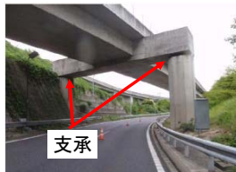
下部構造上の支点が上部構造の橋面の水平投影面上にない場合の例
