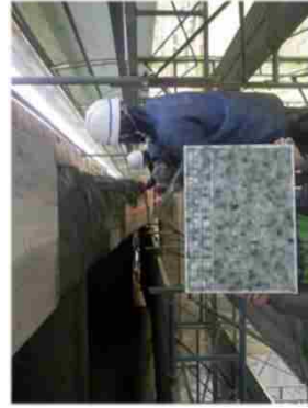
修繕の様子（断面修復）
