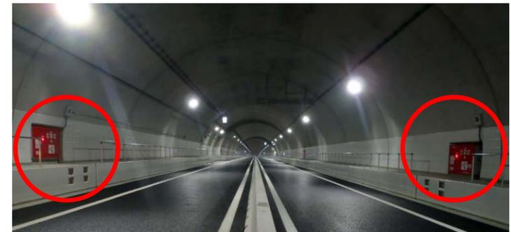
自動通報設備・消火栓設備を両側に設置した例
