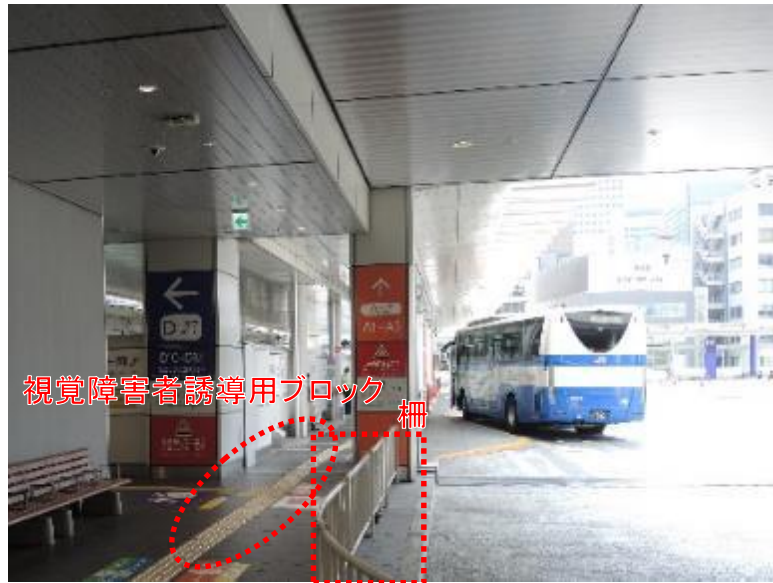
視覚障害者誘導用ブロック・柵
