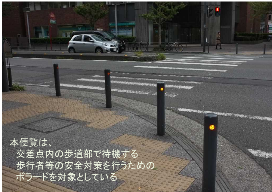
A 交差点の横断歩道接続部等に設置されるボラード
