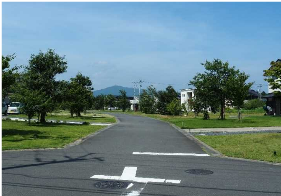
無電柱化した道路（地中化路線）
