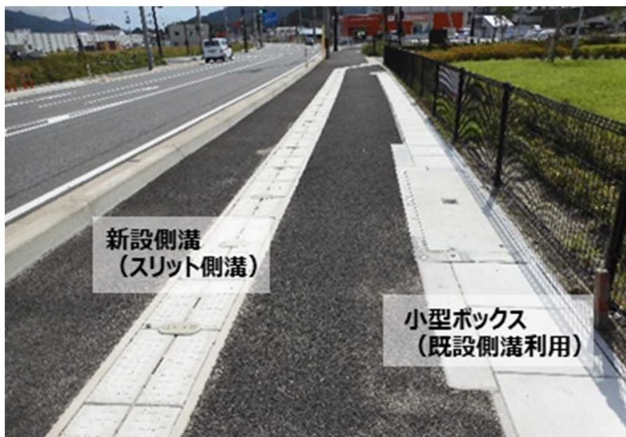
無電柱化後の歩道状況
