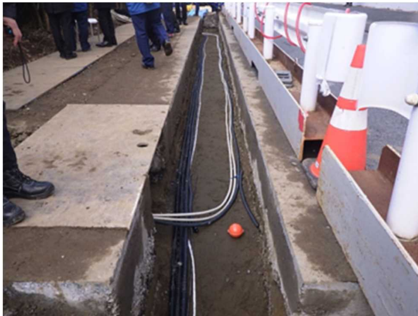
板橋区（R17BPの側道）における実証実験の様子
