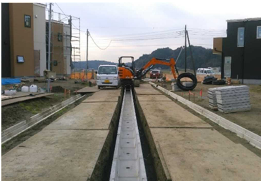
小型ボックス施工中の様子
