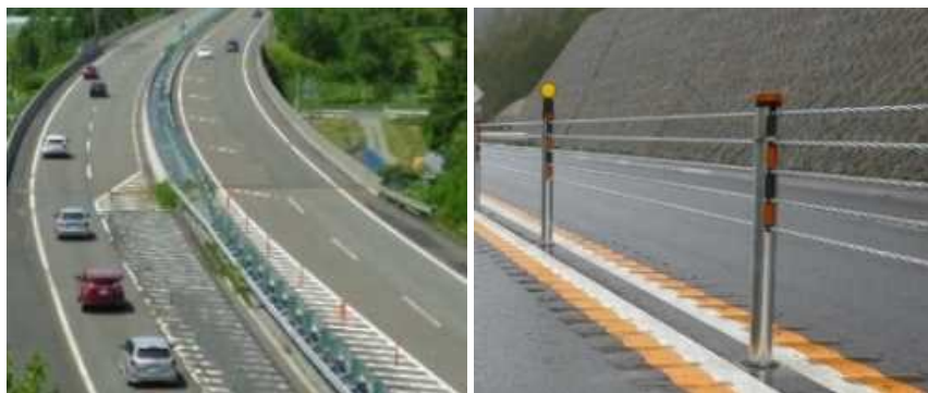
<ワイヤロープの設置事例>
