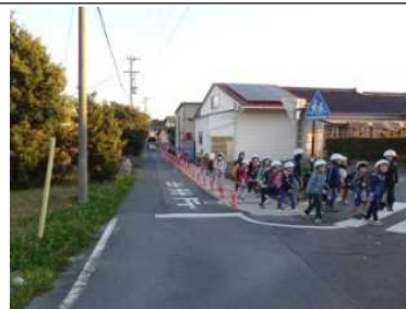
側溝蓋掛けによる歩行空間の確保
