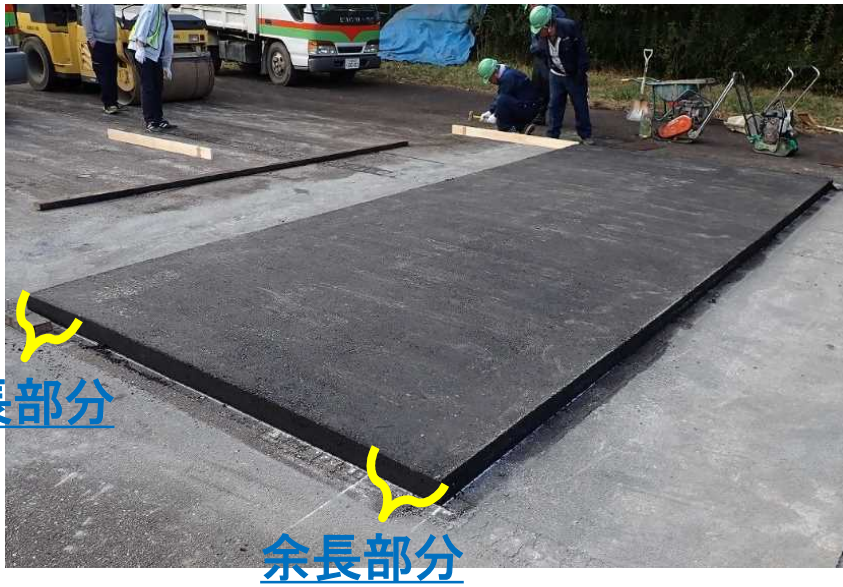
○平坦部の施工
