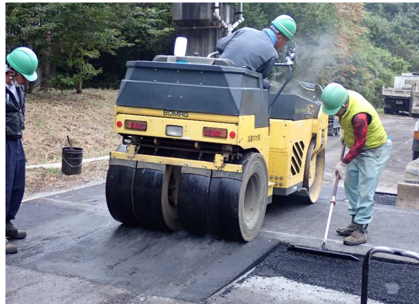
○余長部分の調整(転圧)
