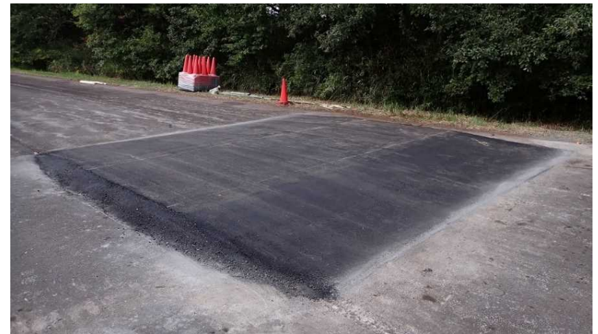
○型枠の撤去・完成
