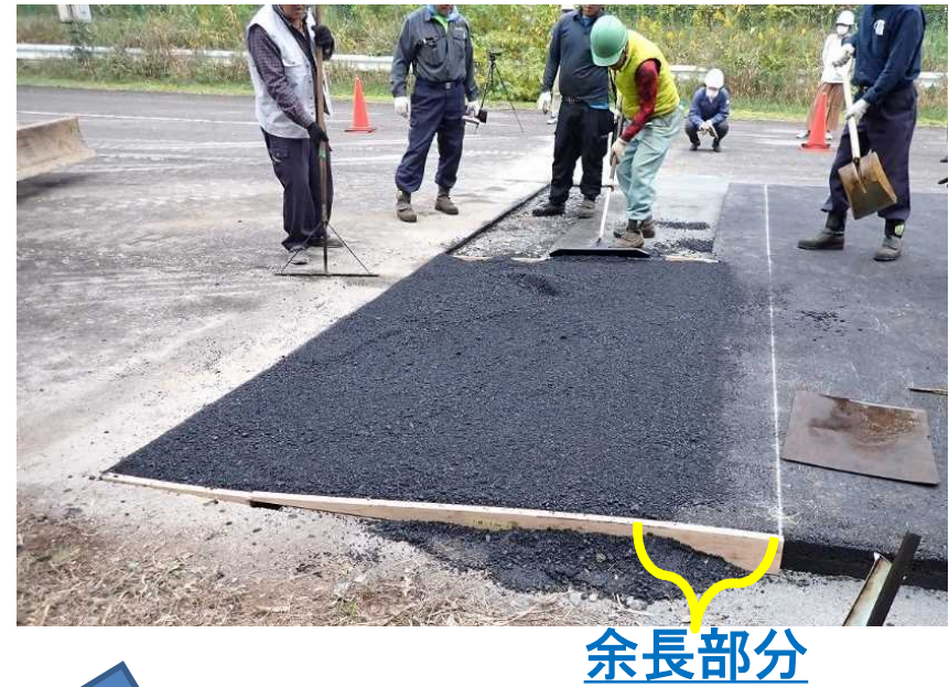
○傾斜部の施工
