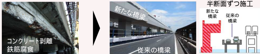
構造物全体の架け替えを実施
