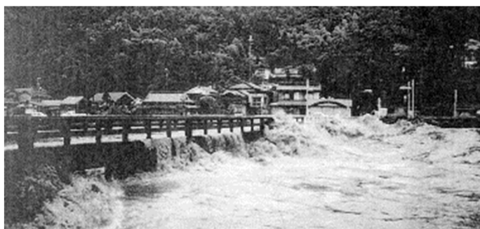
桁下高不足による支障事例
