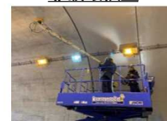
レーザーを利用した トンネル覆工の損傷把握
