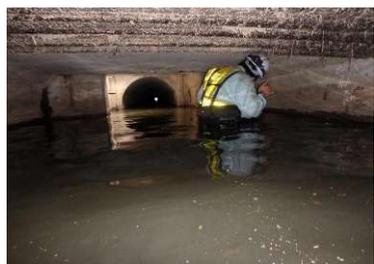
滞水した溝橋内部の目視点検
