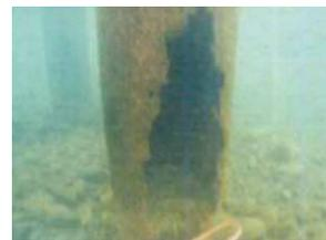
▲橋脚水中部の断面欠損
