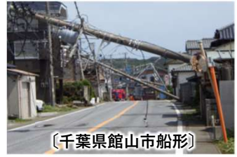
【台風等による電柱倒壊状況】
