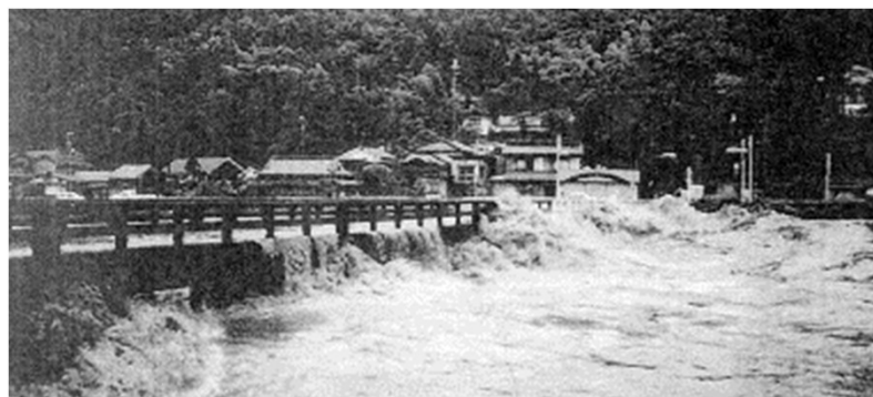
桁下高不足による支障事例
