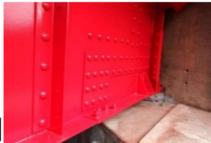
桁端部の当て板・塗装
