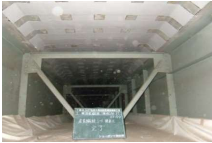
炭素繊維シートの貼り付け
