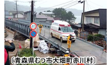
【仮橋設置による応急復旧】
