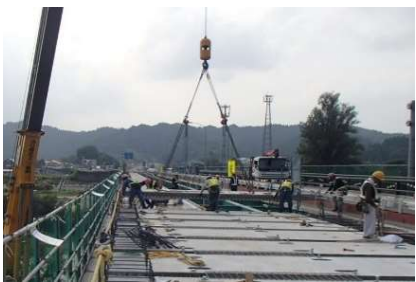
プレキャスト床版による 打ち替え
