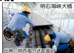
出典：関西電力送配電HP 送電網の収容に道路空間を活用
