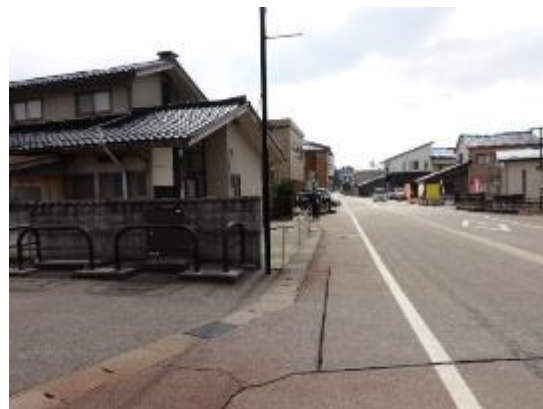
車両通行に支障となる被害はない
