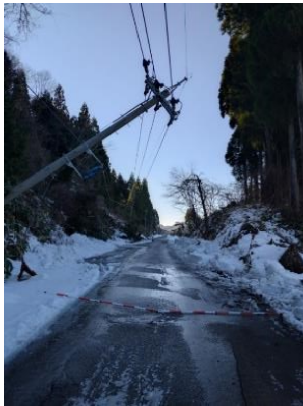
石川県輪島市 広域農道
