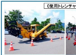
《使用トレンチャー》
