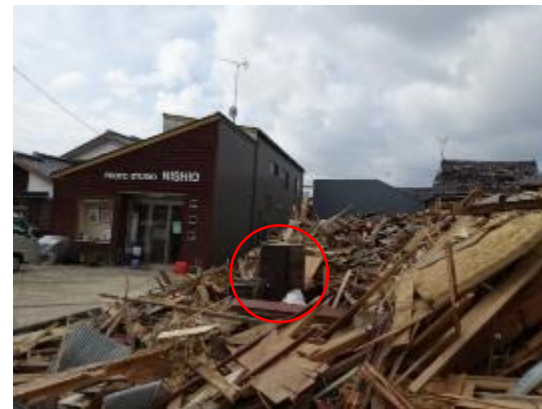
家屋倒壊に巻き込まれた地上機器 (傾いたりはしていない)
