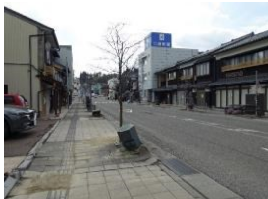
車両通行に支障となる被害はない
