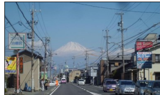
<美観を損ねる電柱・電線>
