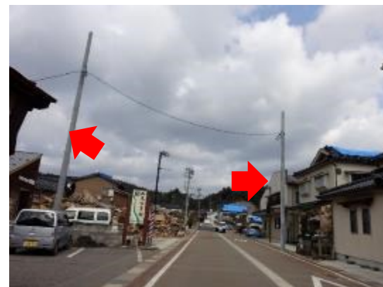
仮設電柱にて応急復旧
