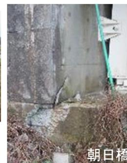
基礎の前面の抵抗の低下や基礎地盤の変位が橋の不安定化をもたらしていることが疑われる例
