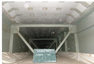
炭素繊維シートの貼り付け
