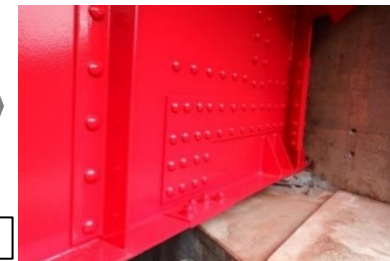
桁端部の当て板・塗装
