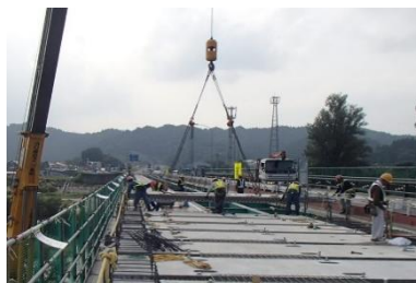
プレキャスト床版による 打ち替え
