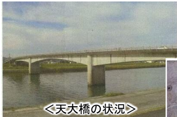
■ 天大橋 (鹿児島県薩摩川内市)
