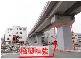
耐震補強例（釜石高架橋）
