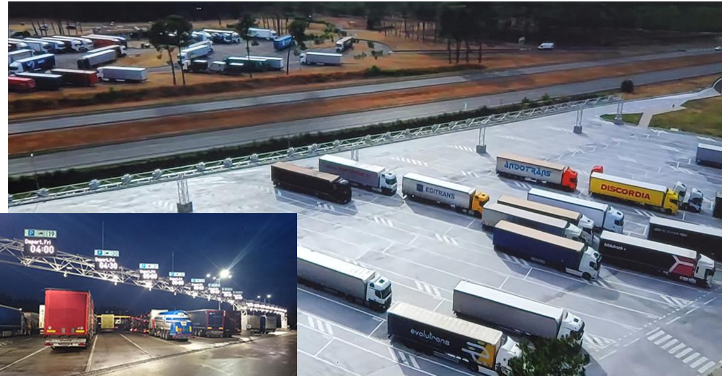
出発時刻に基づいてトラックを仕分ける インテリジェントな小型トラック駐車場
