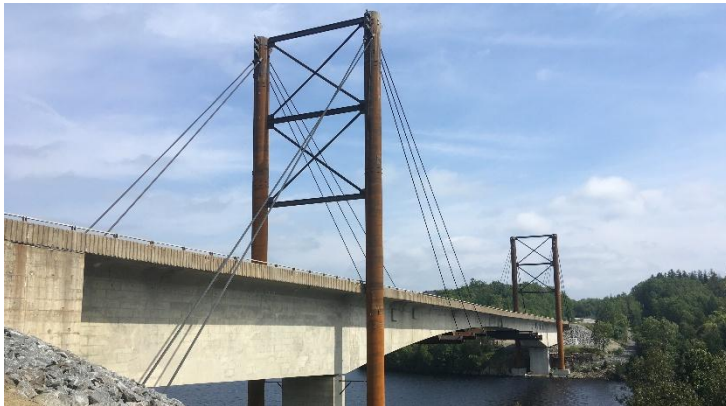
連続PC桁橋へのステイケーブルの追加
