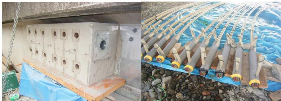
アラミドFRPロッドによるアンカレイジ補強
