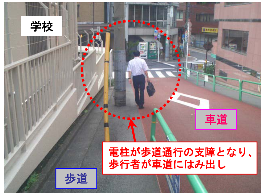
【電柱が歩行空間の障害となる例】
