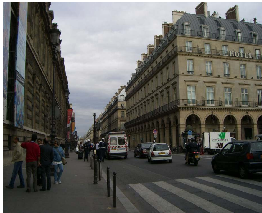
【パリの無電柱化の状況】
