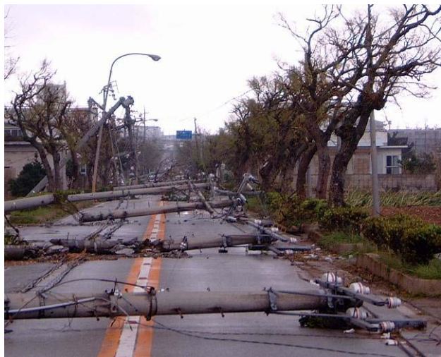
【防災上の阻害】 (沖縄県宮古島市)
