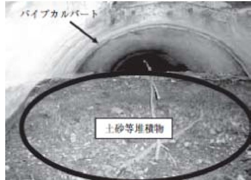
解図1-6 土砂流入による水路カルバートの通水阻害
