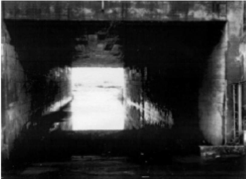
解図1-4 カルバートの沈下による滞水
