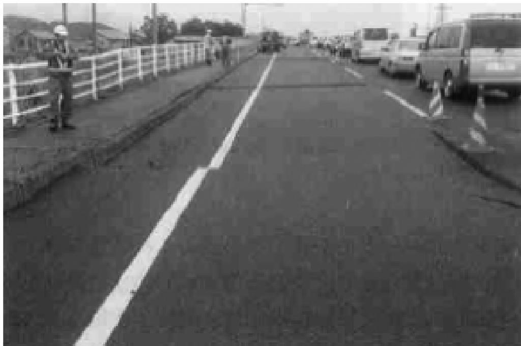
解図1-7 地震によりカルバート区間で発生した段差
