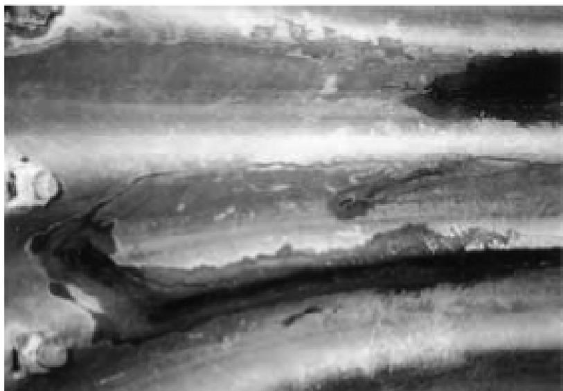
解図1-11 コルゲートメタルカルバートの腐食
