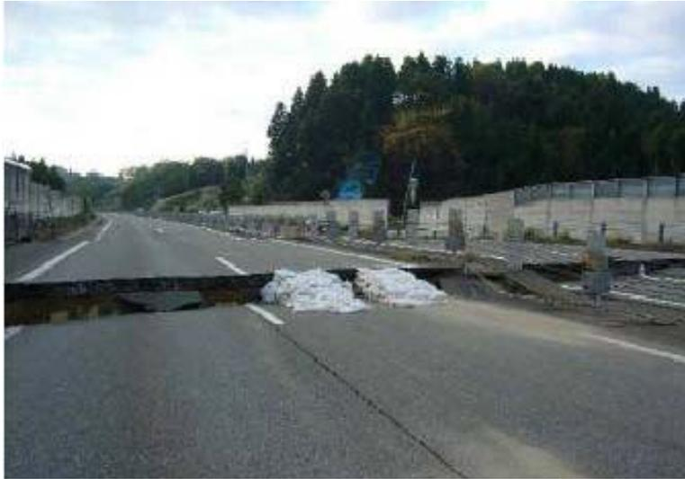
地震によりカルバートと盛土の間で発生した段差の例
