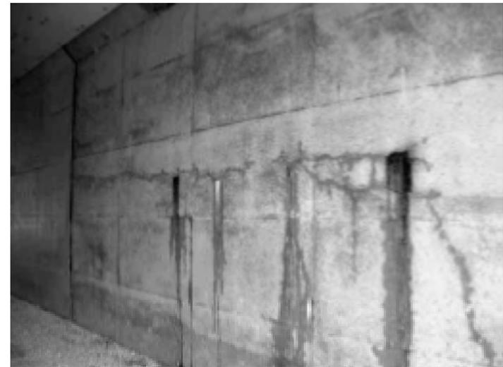
凍上によりボックスカルバート側壁に発生したクラック
