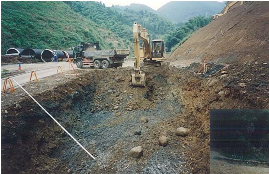
盛土の安定性確保のため、盛土基盤の不良土を撤去し置換を実施します。
