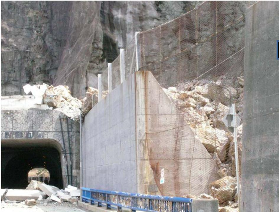
地震により発生した洞門脇の岩盤崩壊
