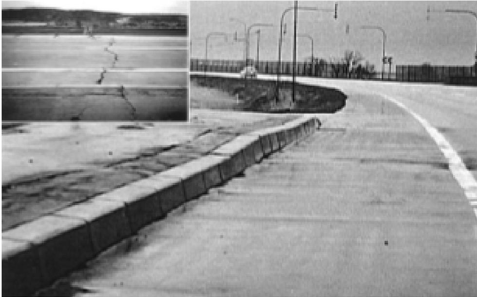
凍上によるボックスカルバート上の舗装の押上げと亀裂
