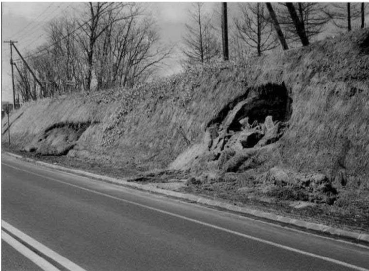
凍上により、切土のり面が被災した例
