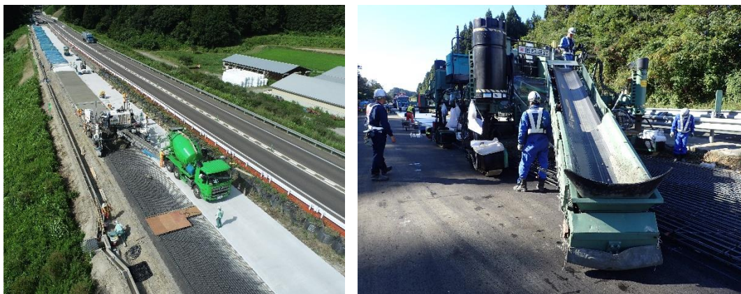
図 3-9 スリップフォーム工法による施工
