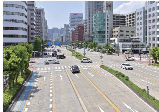
図 1-8 コンクリート舗装
