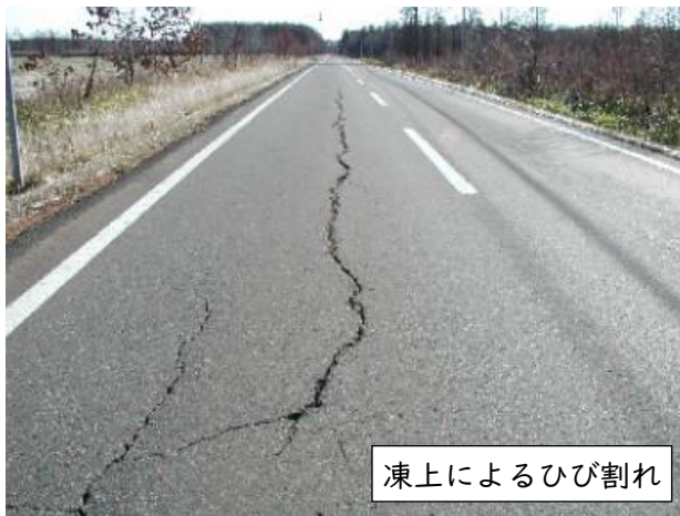
図 3-5 雪国特有の舗装の壊れ方 1)
