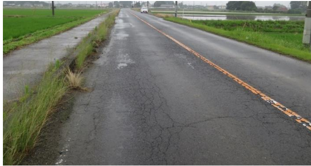
図 3-17 路面調査で確認する舗装の表面
