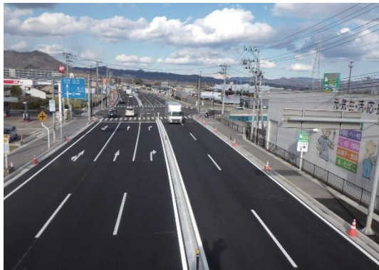
図 1-7 アスファルト舗装
