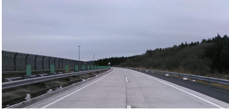
図 3-8 自動車専用道路のコンクリート舗装
