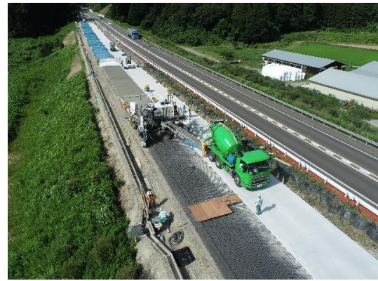
図 1-21 コンクリートフィニッシャ 図 1-22 スリップフォーム工法
