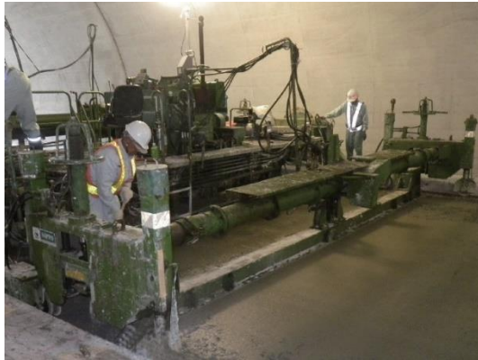
図 1-21 コンクリートフィニッシャ 図 1-22 スリップフォーム工法
